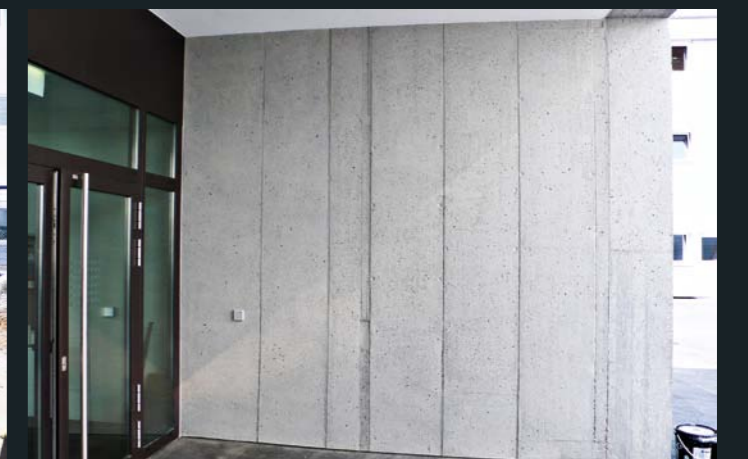
Vollflächige Betonimitation
