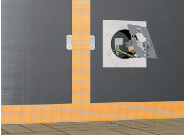
Bild 4: Vom Elektrofachmann im Putz eingebaute und angeschlossene Erdungsplatte EGP.
